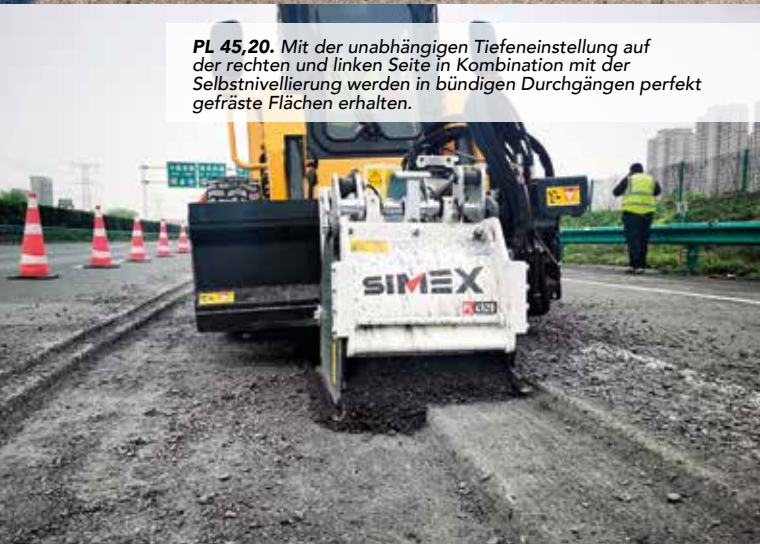
Detail der Frästiefe bei einer Straßeninstandsetzung.
