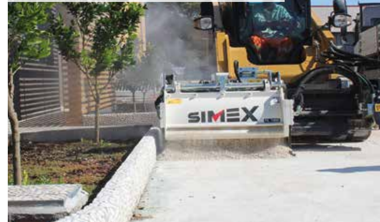
PL 1500. Oberflächen ausgleichen mit bündigen Durchgängen bei der Neupflasterung eines Hafenkais.
