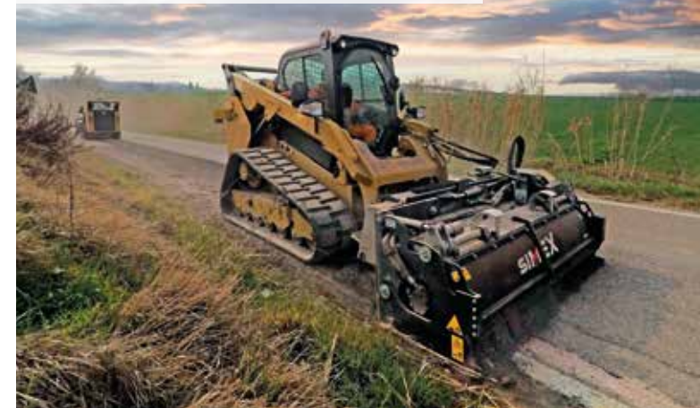
PL 2000. Instandsetzungsarbeiten an beschädigtem Asphalt nach der Verlegung von Glasfasern.
