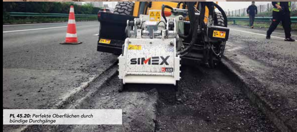
PL 45.20 HP: Instandsetzung von Fahrbahnen.
